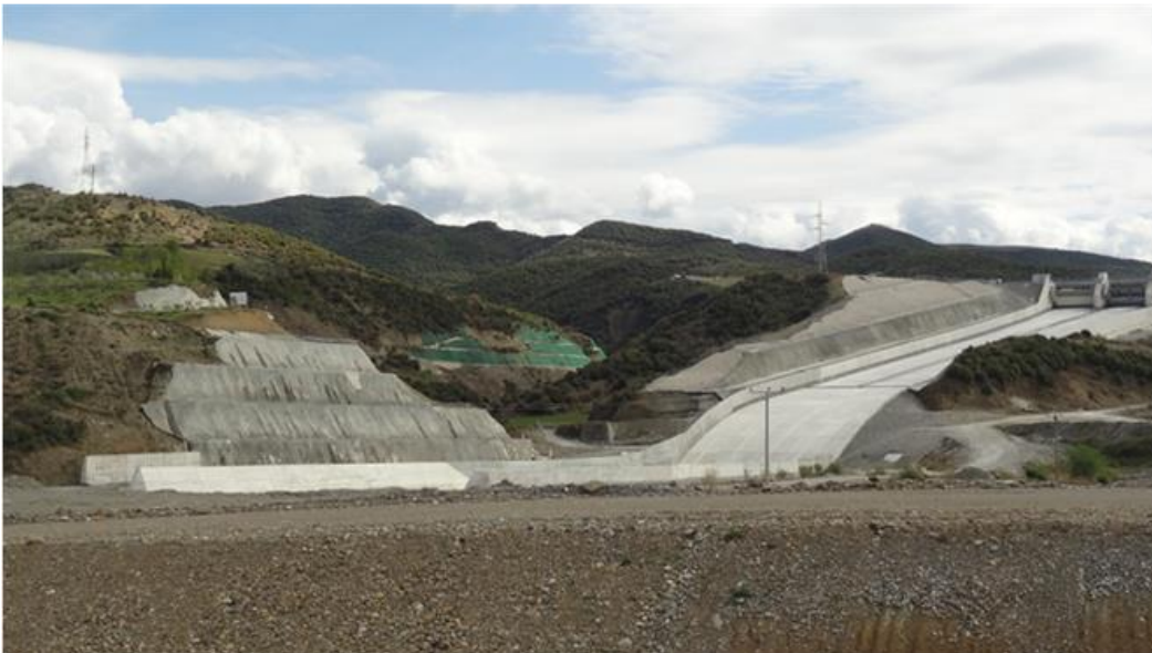
Figura 9: Diga e Banjës – Tregon shkarkuesin nga përmbytjet dhe bankinat mbrojtëse ne bjeftin e poshtëm
